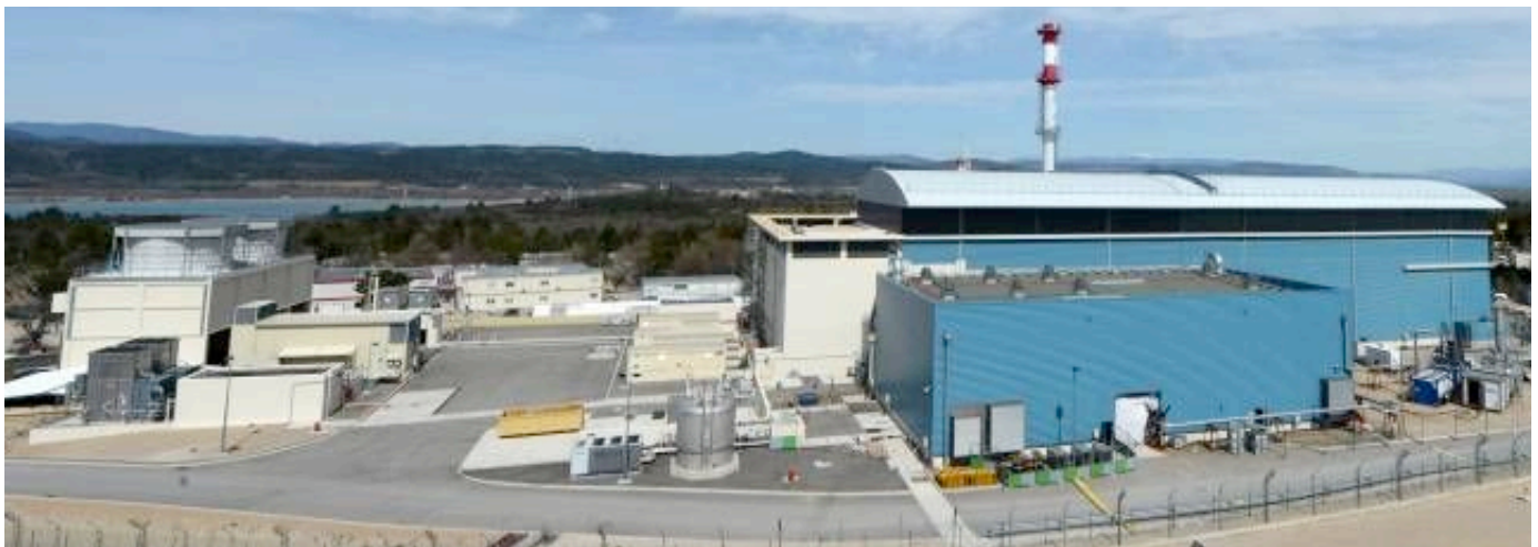
Réacteur d'essai (RES) sur le site de Cadarache (crédit photo : AREVA)
